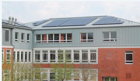
Große PV-Anlage auf Schuldach (Johannes-Althusius-Gymnasium, Albert Alberts-Tammena)
