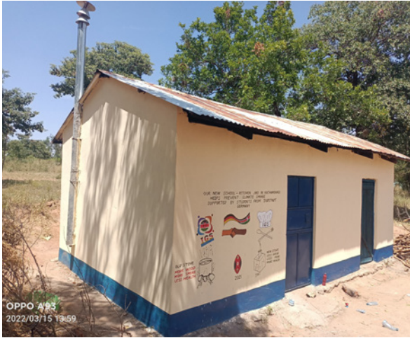
Ein restauriertes Küchenhäuschen an der Kathambangi Primary School finanziert von der IGS Südstadt/Hannover.
