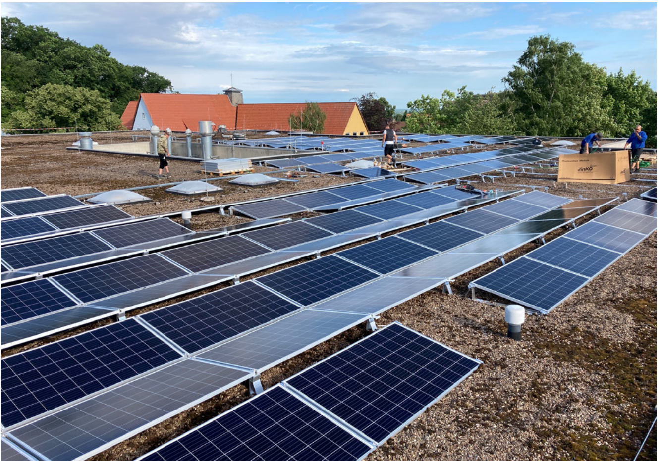
Photovoltaik-Anlage auf dem Dach der IGS Obernkirchen © Landkreis Schaumburg, Nils Althoff.
