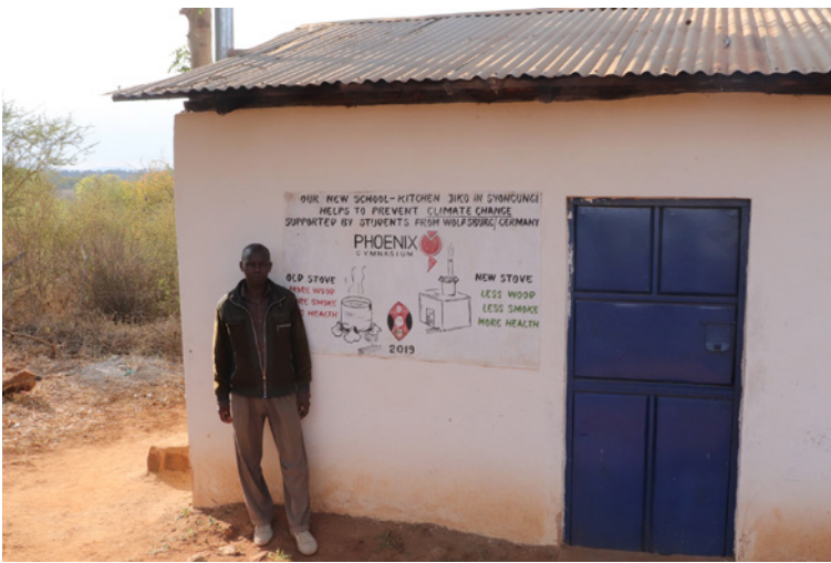
Schulküche mit holzsparendem Schulföfen an der Syongungi Primary School, finanziert vom Phoenix Gymnasium Wolfsburg.
