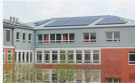
Große PV-Anlage auf Schuldach
